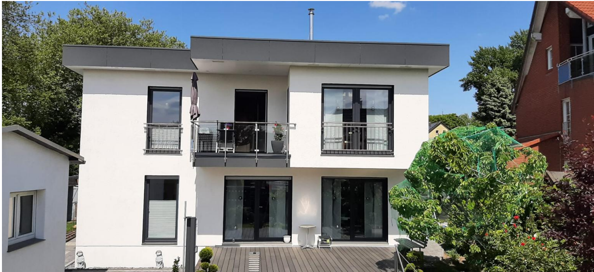
Außenansicht des ersten, realisierten Selbstbauprojekts von "The Future House". Der Bauherr, ein Rentner (67 Jahre), sparte dadurch in wenigen Wochen mehrere hunderttausend Euro. (Abbildung: Romeo Gündling)
